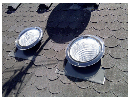
Obr. 5 Grafické znázornění umístění světlovodu do šikmých střech podle zásady č. 1
