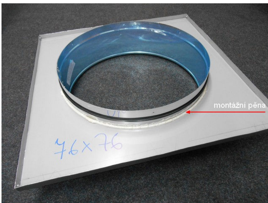
Spodní strana oplechování: Spoj střešního kruhového prstence a oplechování zaizolujeme pomocí montážní pěny.
