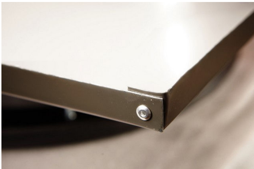
Roh oplechování s nýtem.
