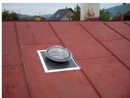
Obr. 7, 8 a 9 Příklady umístění světlovodů v praxi
