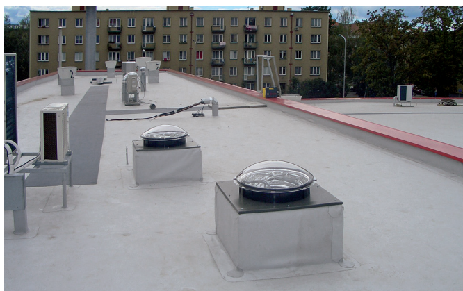
Obr. 10 a 11 Umístění světlovodů ALLUX 850 ULTRA BRIGHT do ploché střechy a podsada pod světlovod
