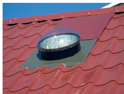
Obr. 6 Grafické znázornění umístění světlovodu do šikmých střech podle zásady č. 2
